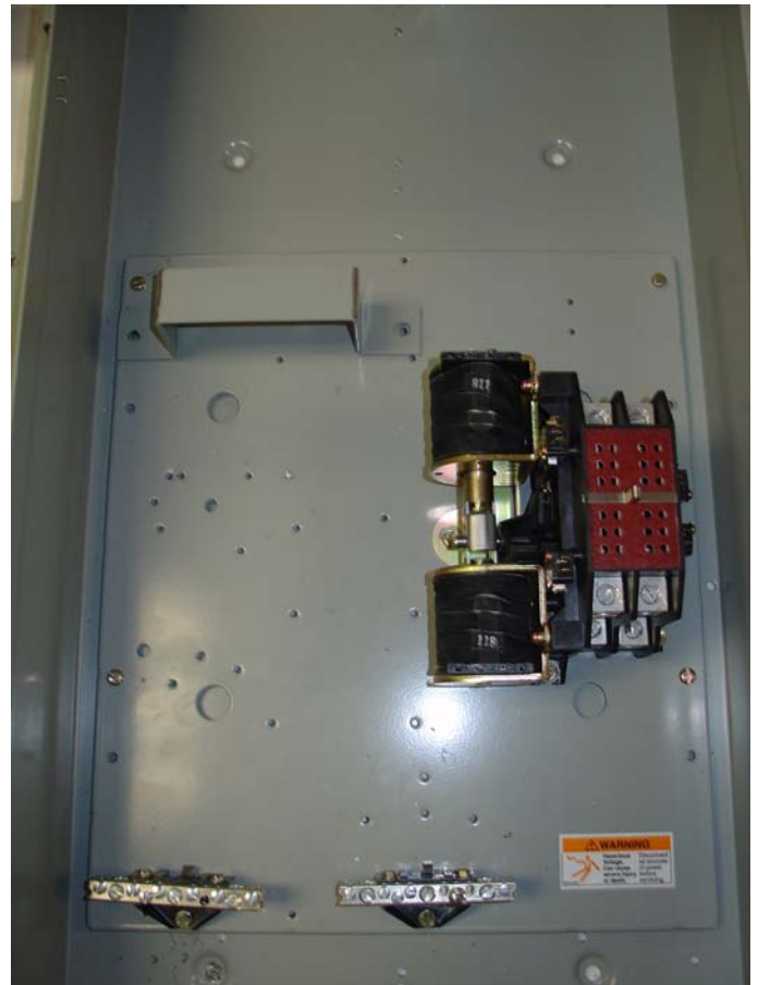
Figure 3 - Commutateur automatique RLC1 (100 A)
