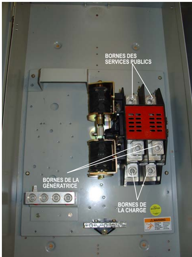
Figure 13 – Bornes de connexion des câbles (200 A)
