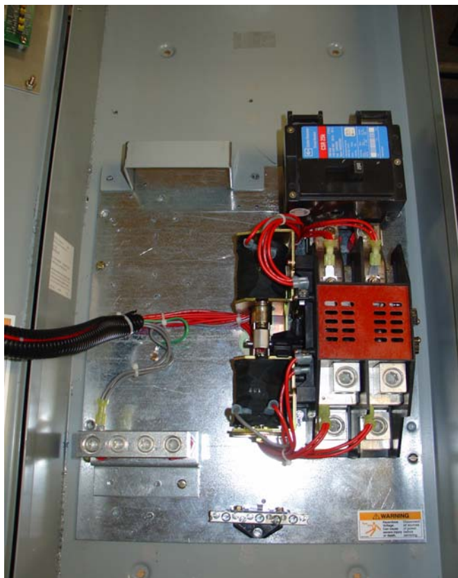
Figure 5- Commutateur automatique RLC1 de branchement de 200 A
