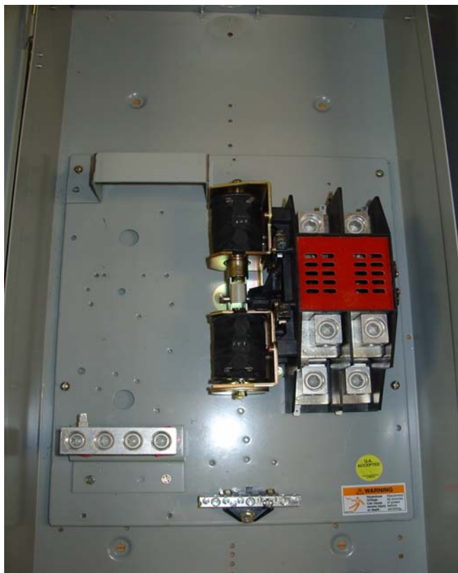
Figure 4 - Commutateur automatique RLC1 standard de 200 A
