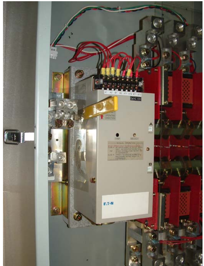
Figure 13 - Manette de manœuvre manuelle d'un commutateur automatique en utilisation
