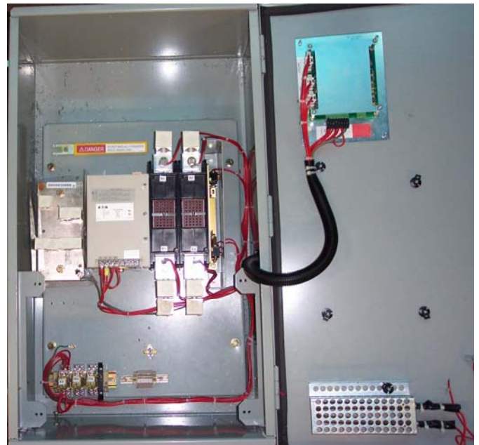
Figure 3 - Commutateur automatique de 400 A
